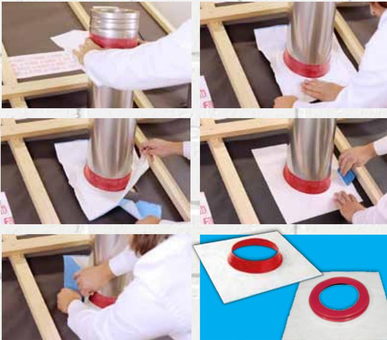
Zur schnellen und dauerhaften Abdichtung von Durchdringungen durch die Dampfsperre oder -bremse, Unterspannbahnen, Holzwerkstoffplatten usw.
